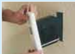
6.) Gerät in die Maueröffnung einschieben und festschrauben.
