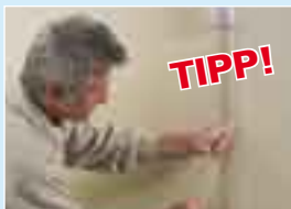
7.) Kabel im transparenten Kabelkanal fixieren.
